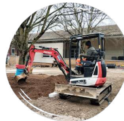
L'école en travaux Décembre 2024
